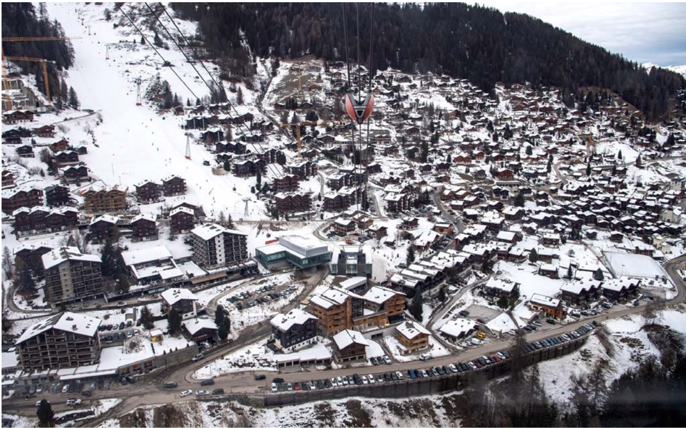
Ces dernières années, la station a connu de nombreux chantiers, y compris de résidences secondaires, grâce aux plans de quartier antérieurs à 2012. HÉLOÏSE MARET/A
