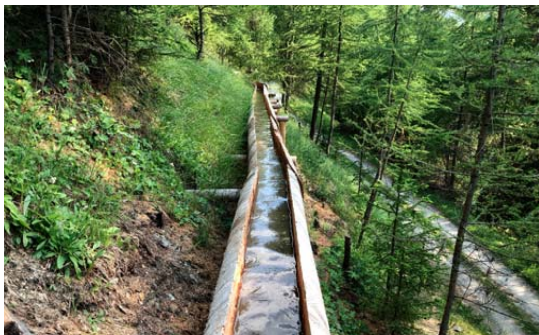
Des «bazots» ont notamment été réalisés pour permettre l'écoulement de l'eau. DR
